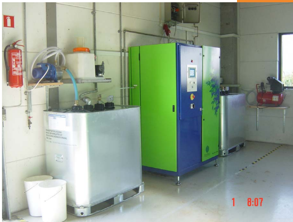
Foto 1 (DSC 02767) Die ENVOTECH-Verdampfer von MKR sind vielseitig im Bereich Werkzeugmaschinen und Oberflächentechnik einsetzbar. Bild: MKR
